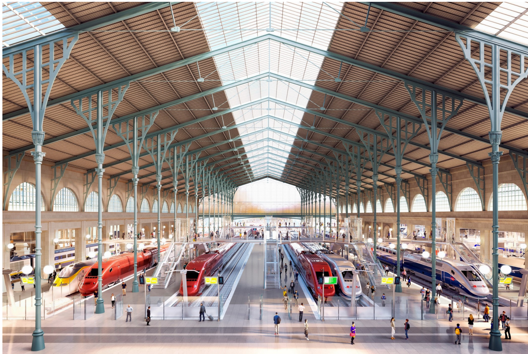
Figure 32 : Alignement des ascenseurs, escaliers fixes et escaliers mécaniques afin de réduire leur impact visuel dans le sens longitudinal de la gare historique
