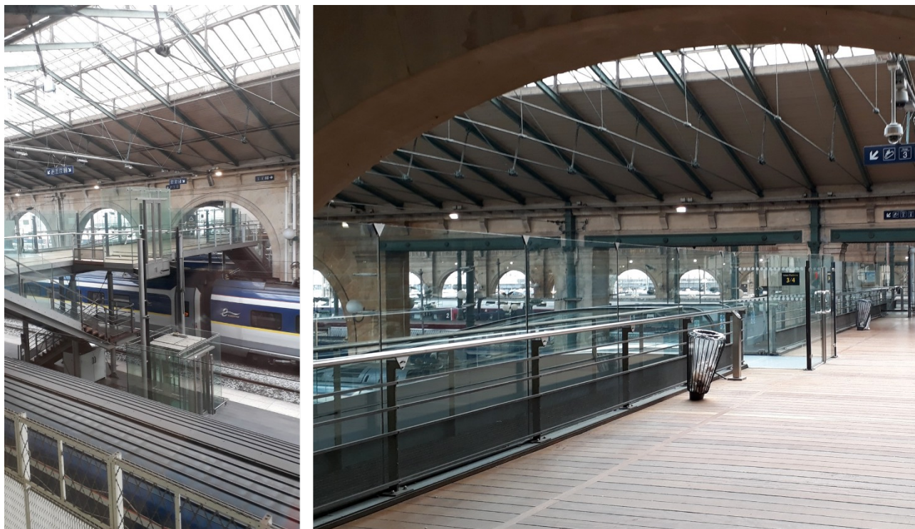
Figure 27 : Les passerelles existantes dans la gare historique qui desservent les quais Eurostar
