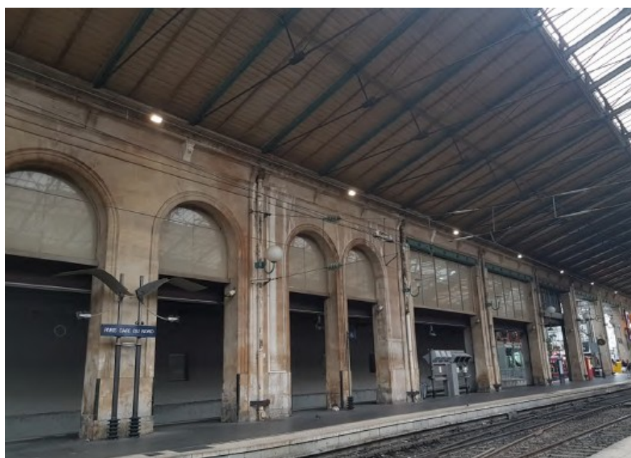
Figure 36 : État initial de la façade ouest, vue depuis les quais
