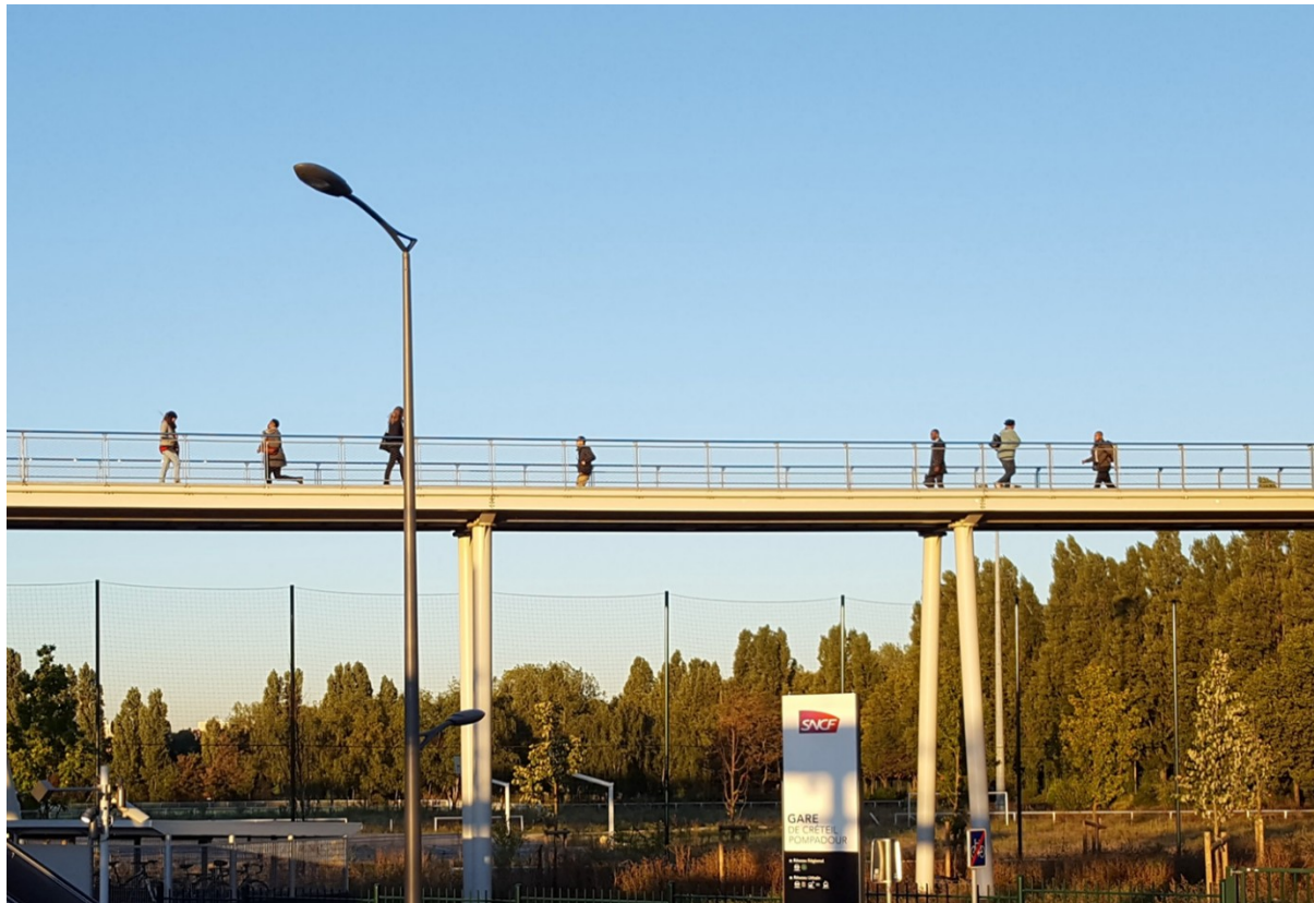
Figure 31 : Passerelle Créteil Pompadour (AREP) avec garde-corps en maille métallique. La finesse de la maille apporte de la transparence et les garde-corps sont quasiment invisibles
